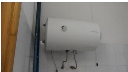
Figura 4.20 - Bollitore elettrico con accumulo - palestra
